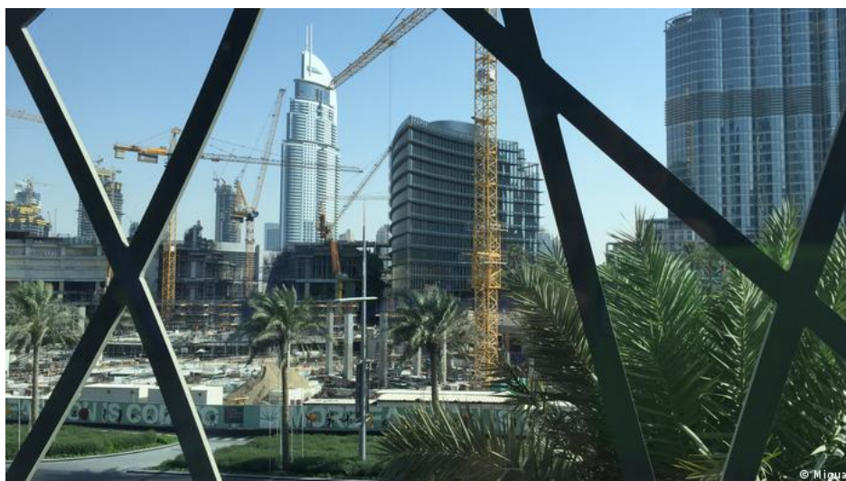
Die Dubai Mall, nach Ladenfläche eines der weltgrößten Einkaufszentren. Auch hier war Migua beteiligt.
