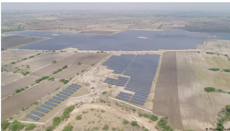
Solaranlage in Karnataka: 2000 KWh pro Quadratmeter
