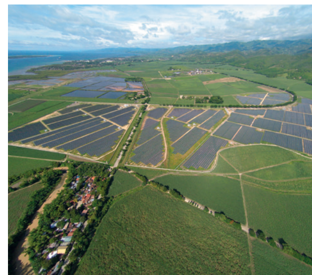
SAN CARLOS SOLAR ENERGY I (SACASOL I)
