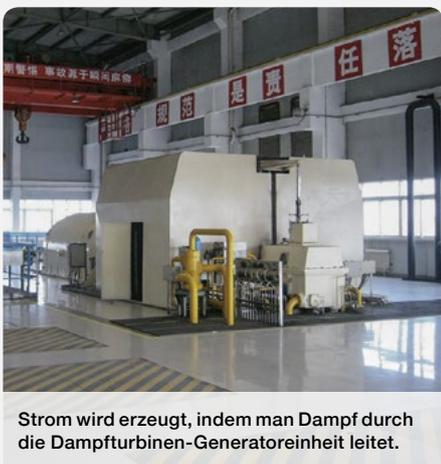
Strom wird erzeugt, indem man Dampf durch die Dampfturbinen-Generatoreinheit leitet.
