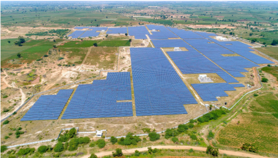
Das Photovoltaikkraftwerk im indischen Bundesstaat Telangana ist das bisher grösste durch den Impact-Investor ThomasLloyd finanzierte Projekt. Es ist im Januar ans Netz gegangen. (Bild: Thomas Lloyd)
