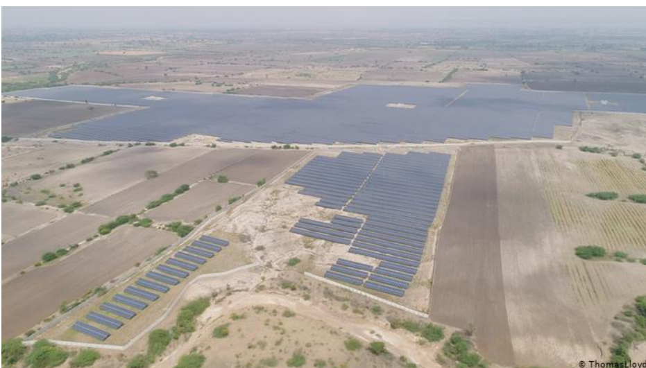
Solaranlage in Karnataka: 2000 KWh pro Quadratmeter
